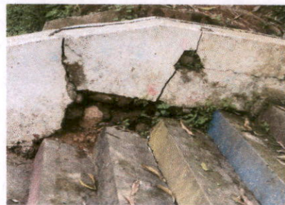
Foto : reparacion de losa
