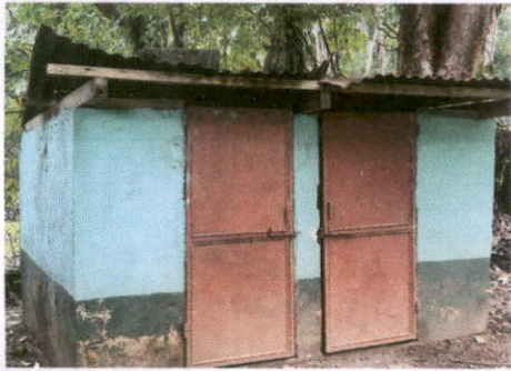
foto 1: mantenimiento a puertas de metal
